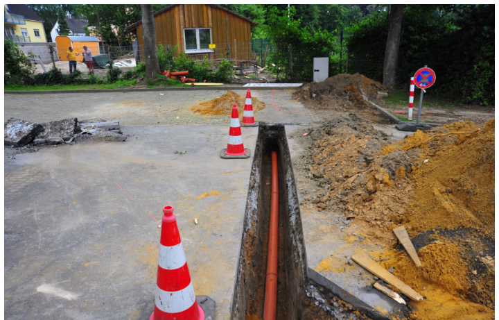
Anschlüsse für Frisch- und Abwasser
