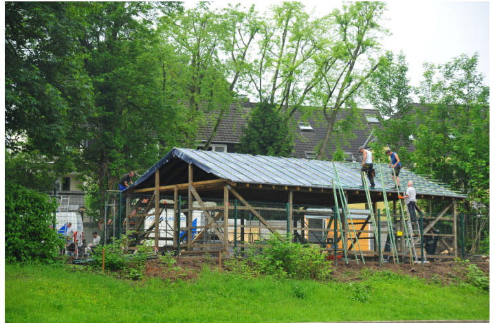
Aufbau der Hütte auf dem neuen Platz
