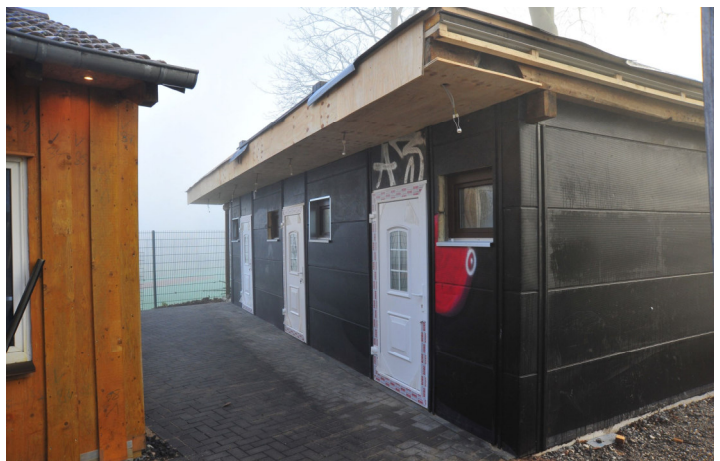
Das neue Toilettenhaus wird größer, näher und auch barrierefrei
