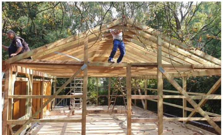
Balkengerippe des Vereinsheims nach vollständiger Demontage der Verkleidung
