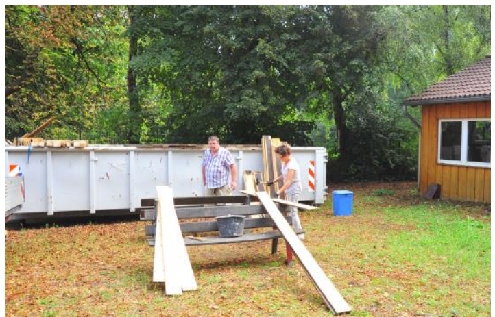
Bretter der alten Verkleidung der Hütte von Nägeln befreien, beschriften und im Großcontainer verstauen
