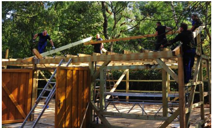
Rückbau der Dachkonstruktion durch Dieter Würzinger und Team, sowie einiger schwindelfreier Helfer
